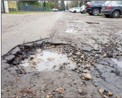
Der Zustand der Lützowstraße in Lichtenrade ist katastrophal.
